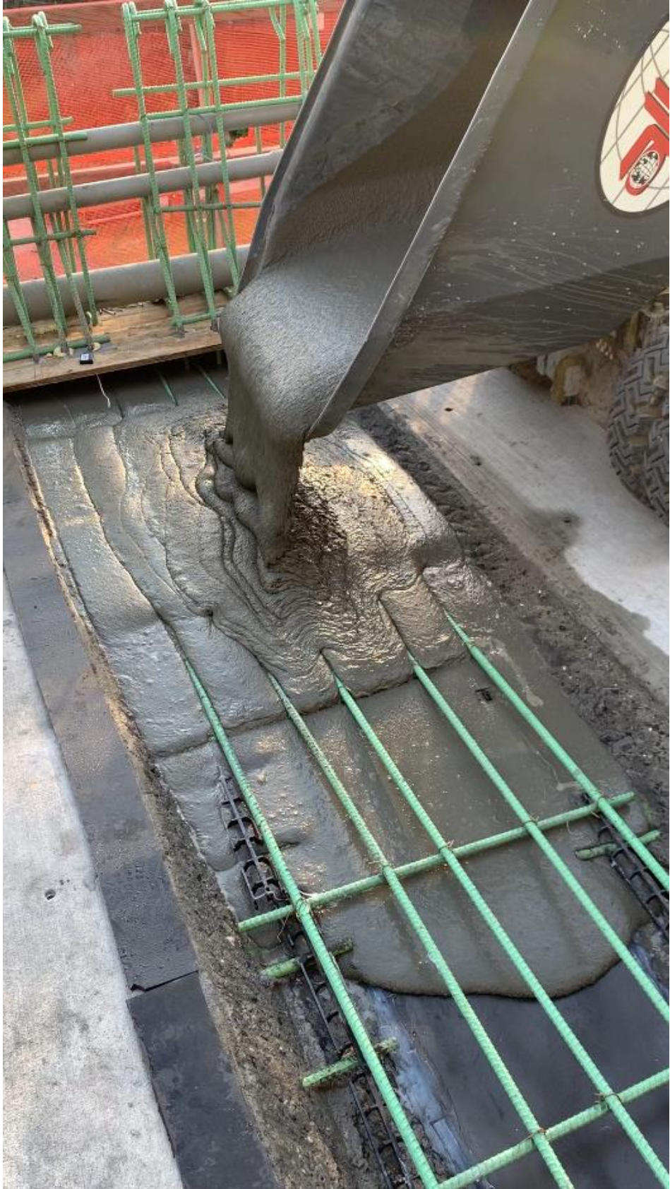
Photo 1: Link Slab Pour
