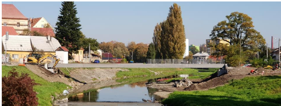
Figure 7. Footbridge in Příbor before completion
